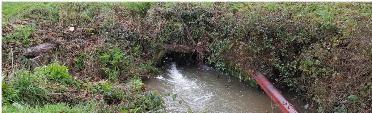
Vue d'ensemble de l'arrivée d'eau avec l'exutoire des différents réseaux
