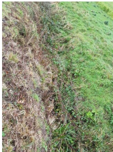
Lit du cours d'eau envahi par la végétation
